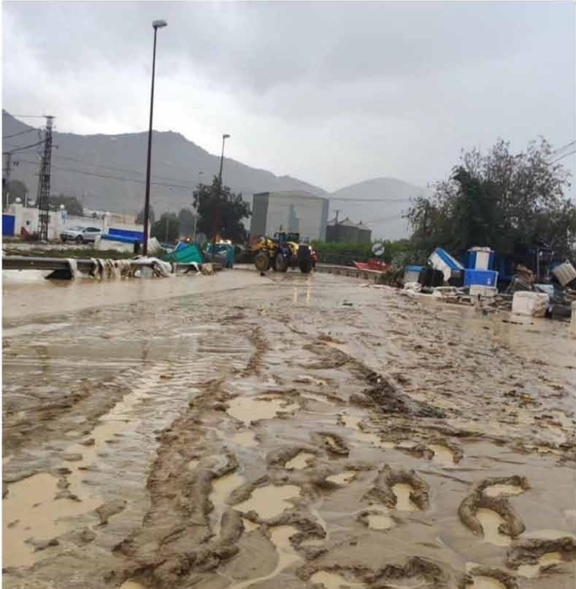
Una gran cantidad de barro y cañas ha colapsado la A-7057 en Cártama.
